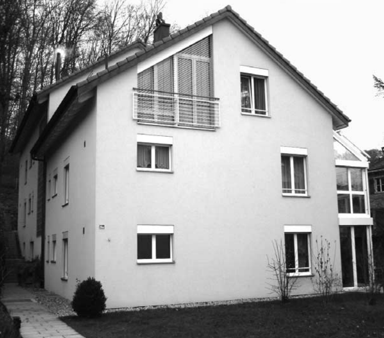
Mehrfamilienhäuser an der Margarethenstrasse in Bottmingen
