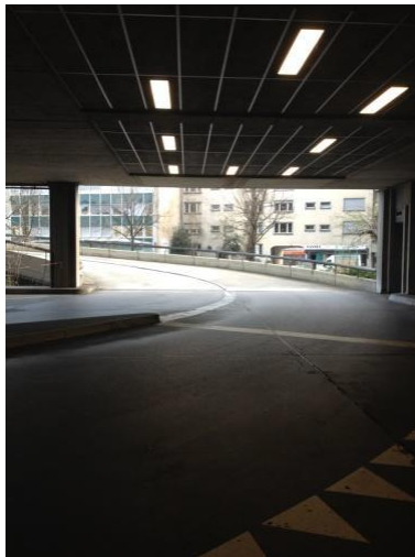
Auffahrt (Schnecke) in das Post Parking.
